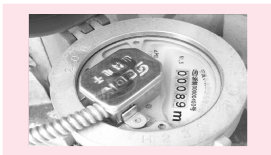
图2 对流量数据采集的智能远传水表
